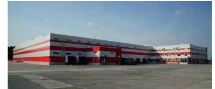
Распределительный центр «Магнит», площадь 19 700 м 2 , Смоленская обл.
