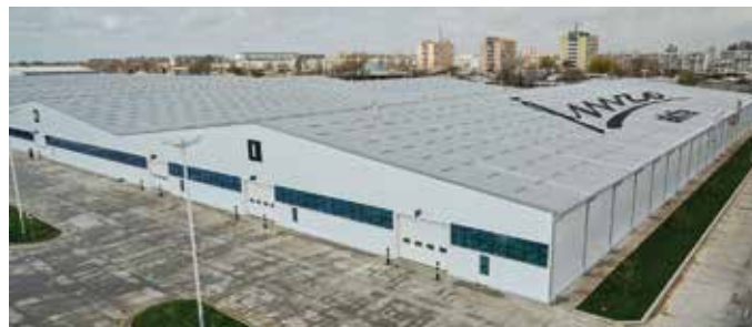
Фабрика оконных конструкций, площадь 76 тыс. м 2 , Узбекистан
