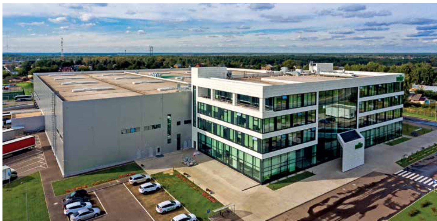
Производственно-складской корпус, площадь 17 500 м 2 , Московская обл.
